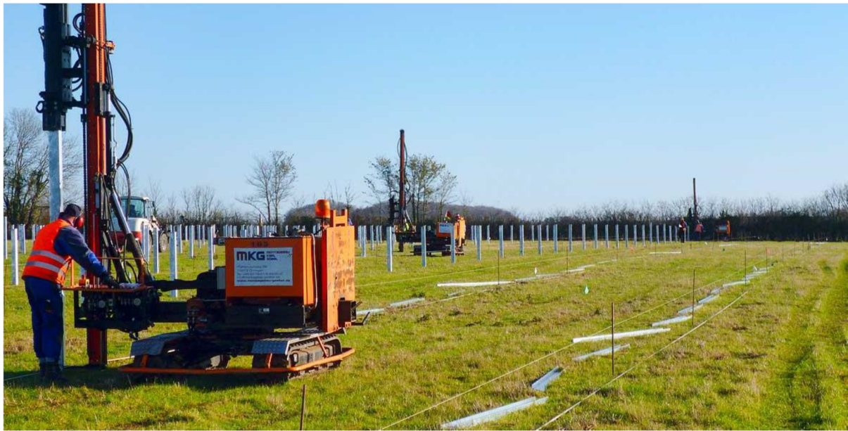
Abbildung 3: Rammgerät zur Installation der Pfosten einer Agri-PV-Anlage (Quelle: GPSS S.A. [1])
