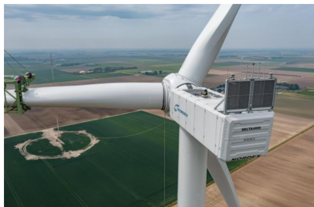
Figure 34 - Schéma représentant les éoliennes prévues d'une hauteur de moyeu de 164 m et d'un diamètre de rotor de 163 m (nordex 2022)
