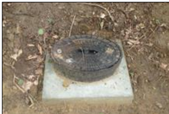
Figure 5. Exemple d'un system de fermeture par taque hydrant
