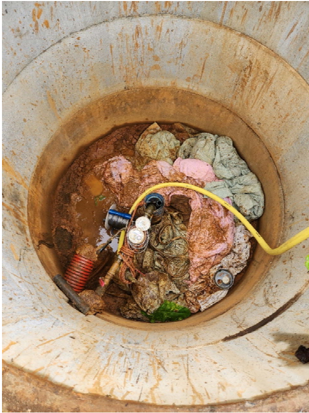
Blick in den Brunnenschacht
