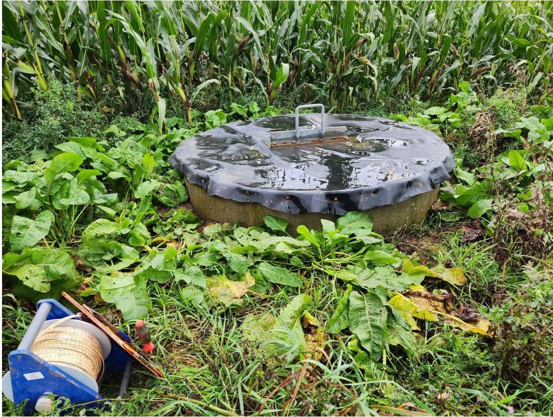
Brunnenschacht mit Abdeckung
