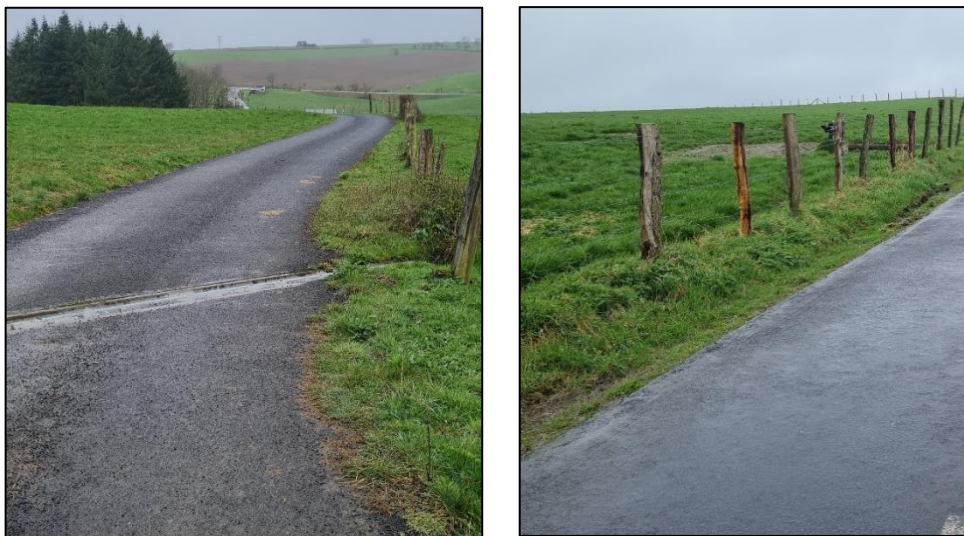
Abb. 42: li.: Bestehender Asphaltweg mit Querrinne zur Entwässerung; re.: Entwässerungsrinne am Straßenrand (Quelle: LSC Environmental Engineering 03.04.2024)
