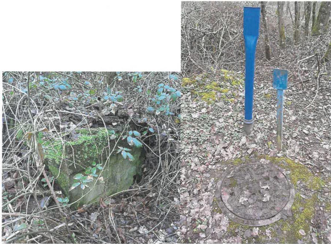
Abbildung 19: Mauerwerk der unterirdisch verlaufenden Wasserläufe östlich des CR322 (links) und Kanaldeckel im nördlichen Bereich des Lagerplatzes (rechts). Quelle: eigene Aufnahme, März 2024.
