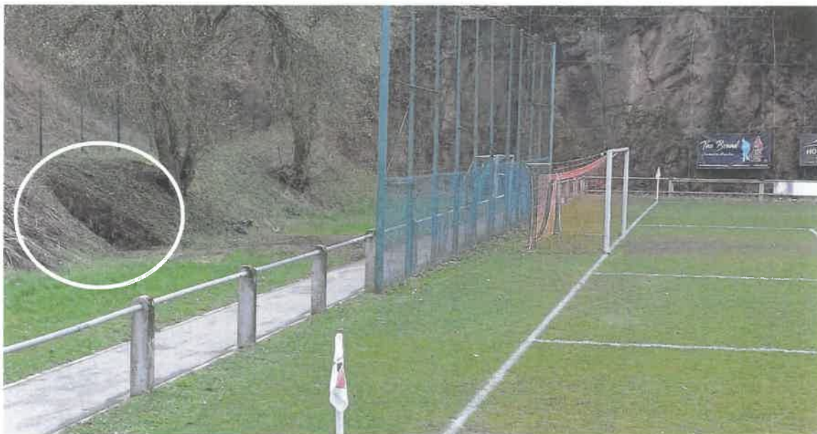
Abbildung 20: Böschung zwischen Lagerplatz und westlichem Spielfeld; ausgespülter Hangfuß (weiß umrandet). Quelle: eigene Aufnahme, März 2024.
