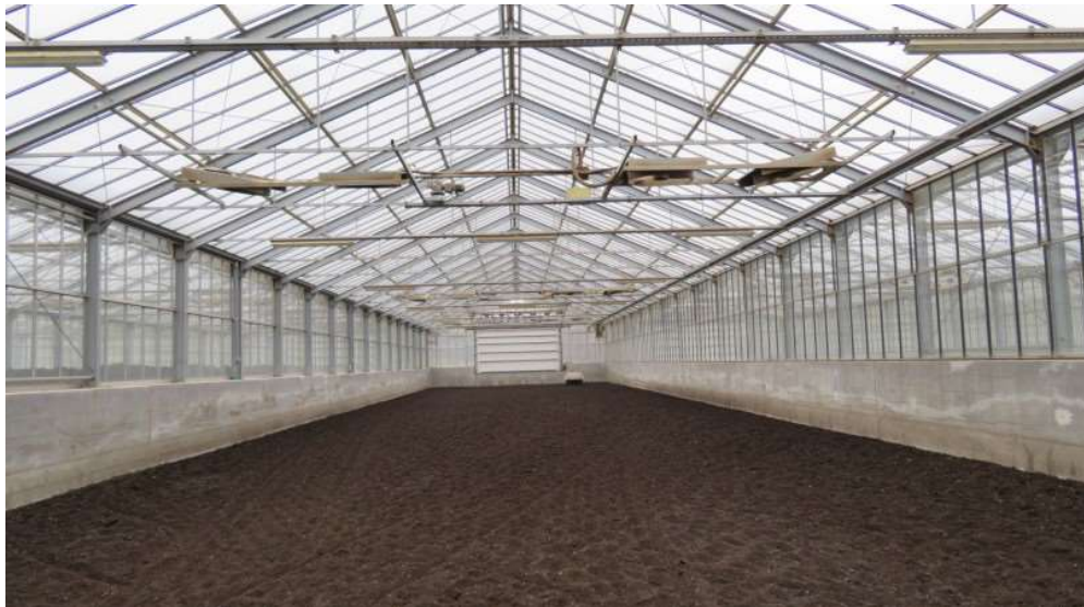
Abbildung 21: Schlammtrocknung
