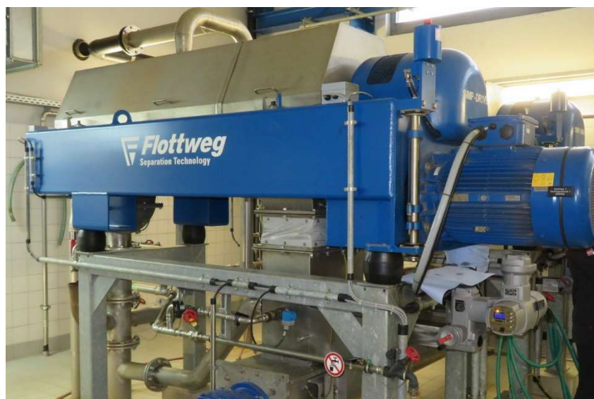
Abbildung 20: Schlammmentwässerung - Zentrifugenanlage
