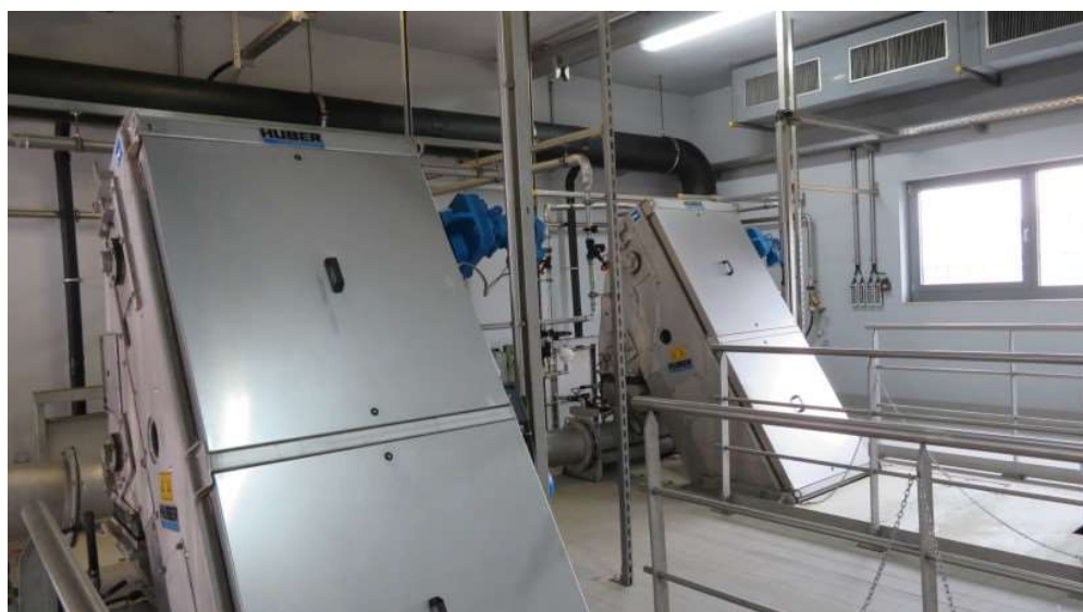
Abbildung 14: 2-stufige Feinrechenanlage
