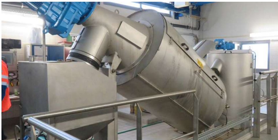
Abbildung 18: Schlammeindickung ÜSS - Eindickpresse
