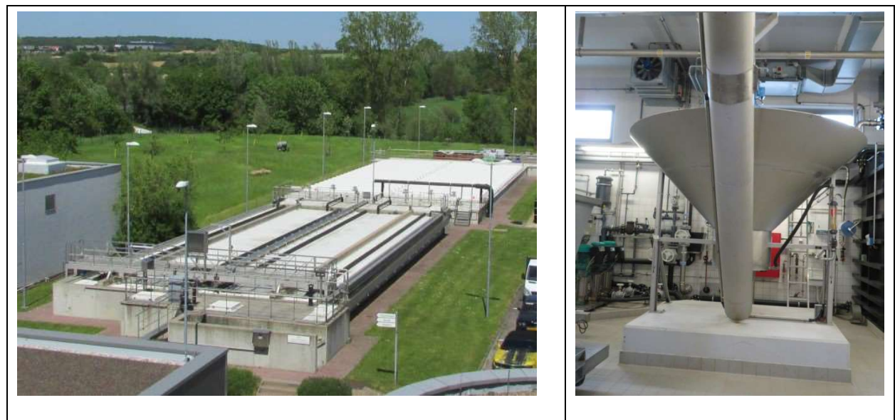
Abbildung 15: 2-straßiger Sand-/Fettfang (links) und die Sandwäscher (rechts)
