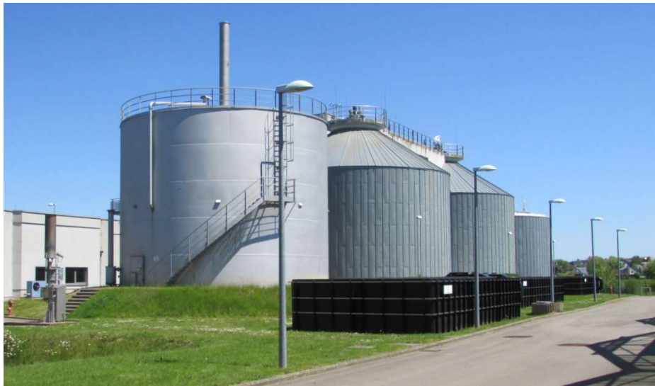
Abbildung 19: Gas- und Faulbehälter
