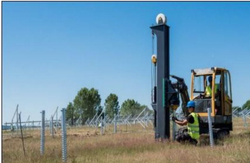
Abbildung 21: Montage der Ankerschrauben für die Modultische (Quelle: EtherEnergy).
