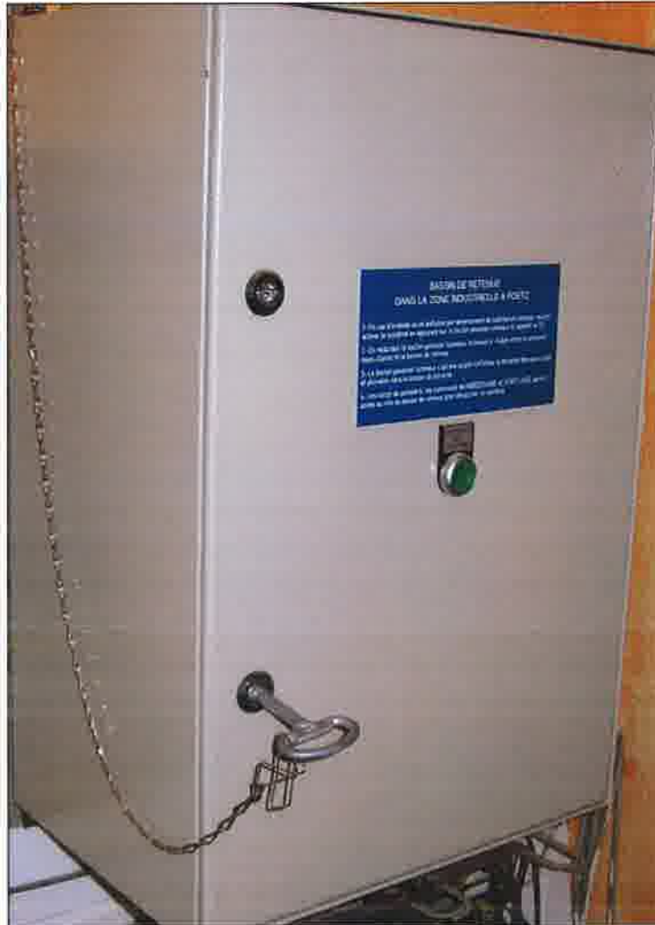
Image 4 : Coffret de commande locale avec bouton poussoir
