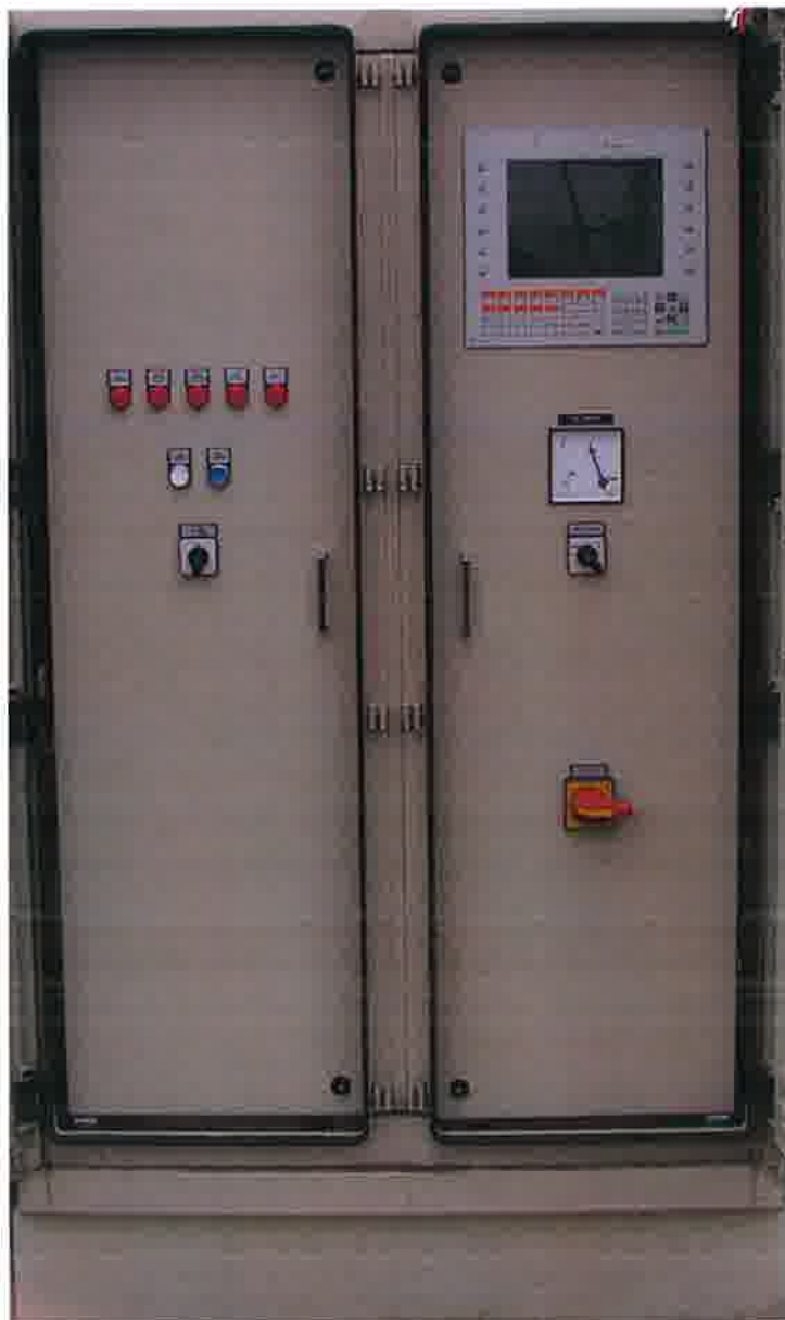
Image 6 : Armoire de commande avec commutateur
