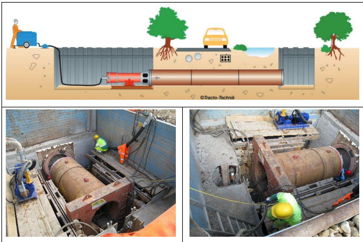
Abbildung 55: Schema grabenloses Bauverfahren (Rammvortrieb) [38] sowie Beispielfotos einer Straßenunterpressung
