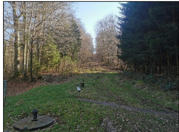
Abb. 2-3 & 2-4: Schneiden in Waldflächen, unter denen die bestehende Leitung verläuft; diese werden dauerhaft „gehölzfrei“ gehalten.
