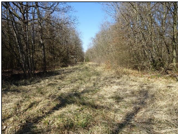
Abb. 2-3 & 2-4: Schneiden in Waldflächen, unter denen die bestehende Leitung verläuft; diese werden dauerhaft „gehölzfrei“ gehalten.
