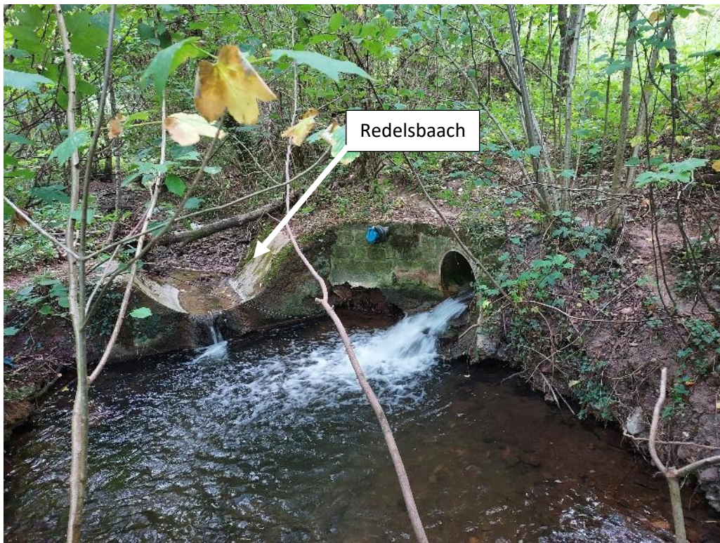
Figure 22: Photo du rejet de la STEP dans le Redelsbaach (Luxplan, juillet 2022).
