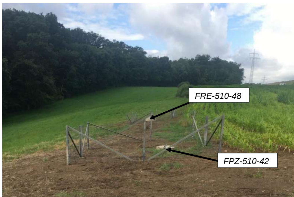
Figure 4 : Regards protégés des ouvrages captages FRE-510-48 et FPZ-510-42.
