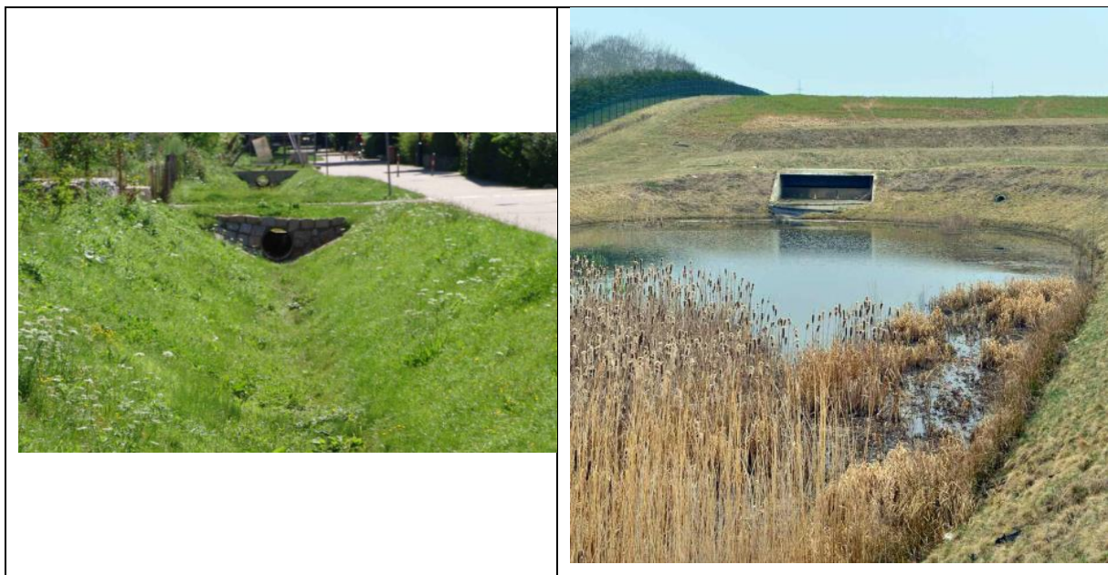
Abb. 166: Vorschlag zur Gestaltung links: der offenen Gräben im Bereich der Servitude CV/CE, rechts: eines offenen Retentionsbeckens (Quelle: Papaya S.A. 20223). Weitere Details in Anhang 13.
