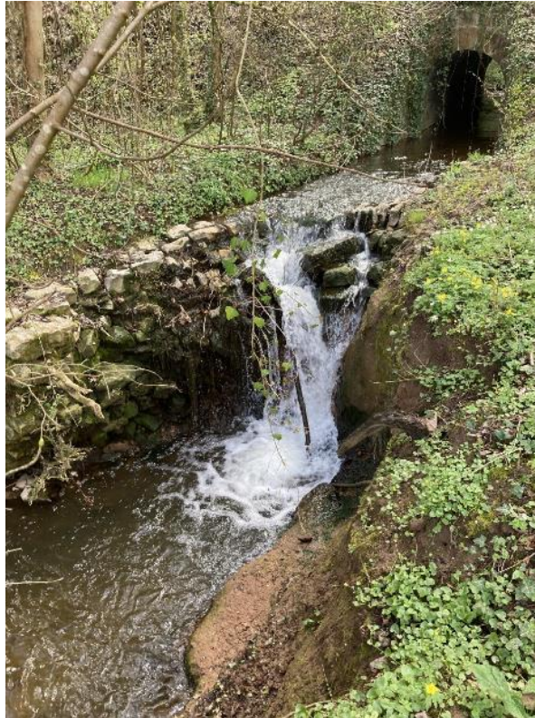
Figure 3: ouvrage infranchissable en aval de la voie de chemin de fer (Luxplan, avril 2023)
