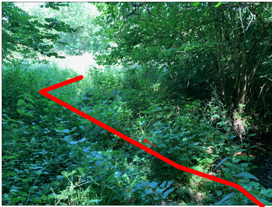
6) sortie tunnel: conduite avec isolation thermique après pose avec couverture min de 80 cm
