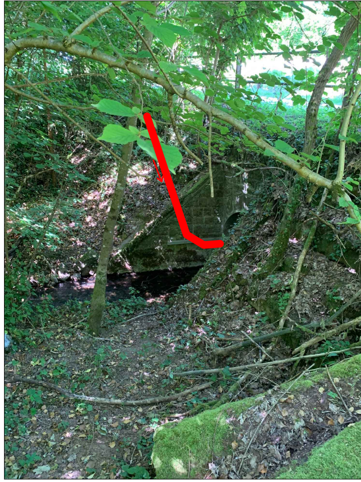
4) entrée tunnel: conduite avec isolation thermique passage par mur
