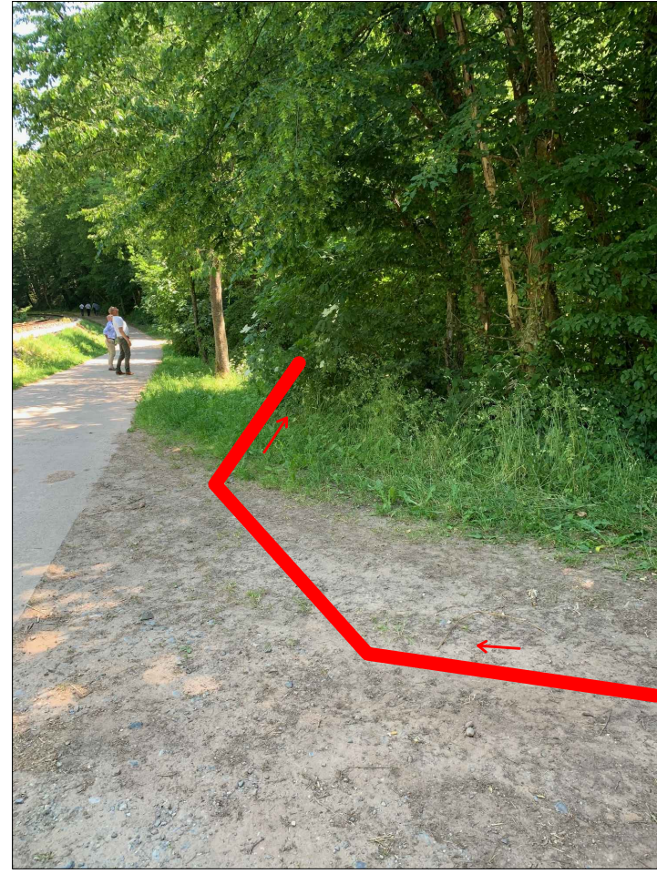
2) pose de la conduite dans le chemin et de la zone verte avec couverture min de 80 cm
