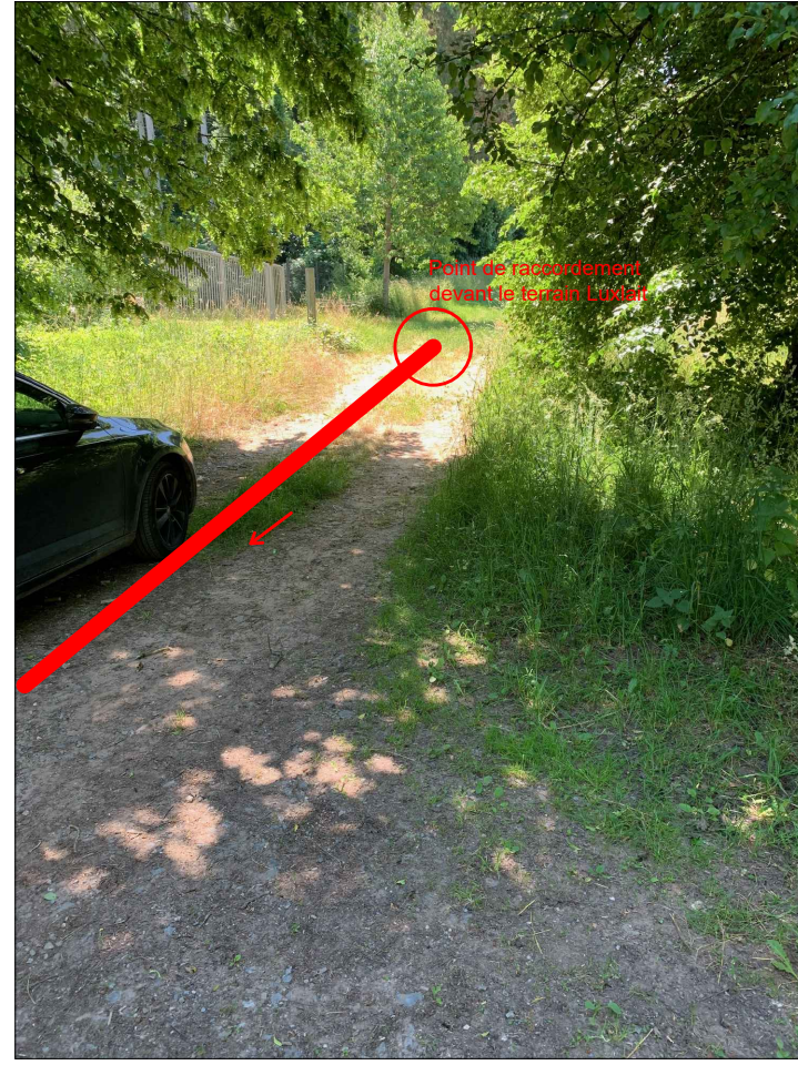
1) pose de la conduite dans le chemin avec couverture min de 80 cm
